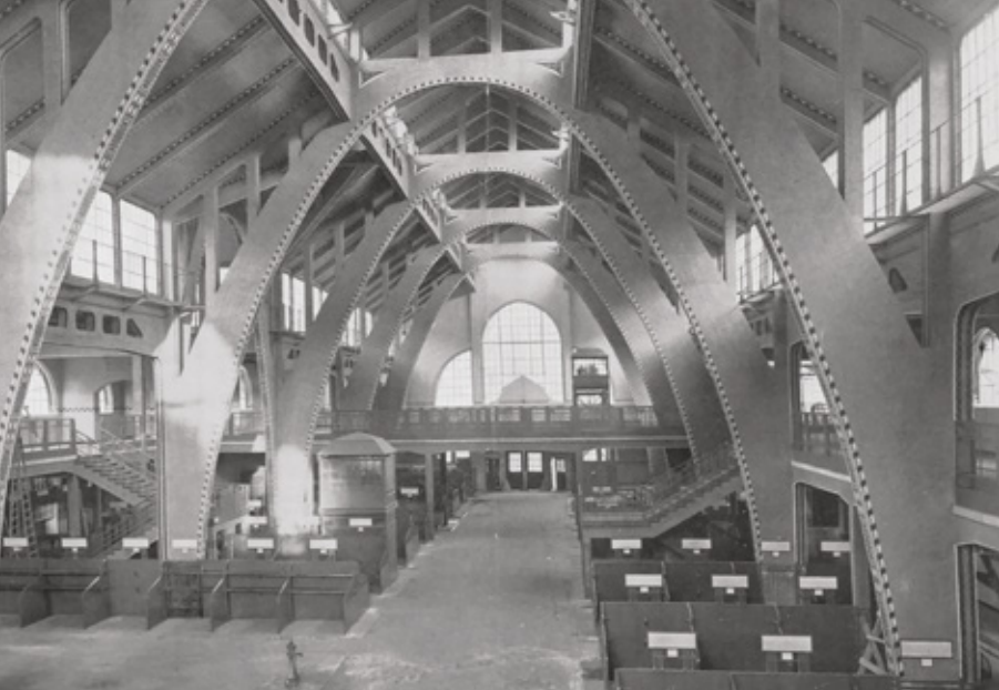
Wnętrze Hali Targowej nr 1 we Wrocławiu, proj. betonowej konstrukcji: Heinrich Küster / Interiér Hali Targowej č. 1 ve Vratislavi, projekt betonové kontrukce: Heinrich Küster
